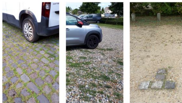
Matériaux de désimpermeabilisations partielles des sols des parkings (Le Mans, Le Havre, La Roche-Guyon)
